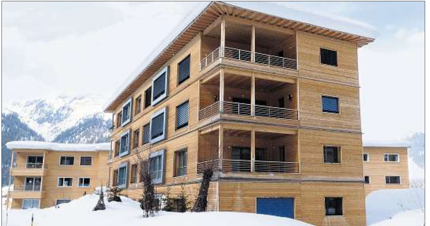
Massive Holzkonstruktionen im Minergiestandard.
