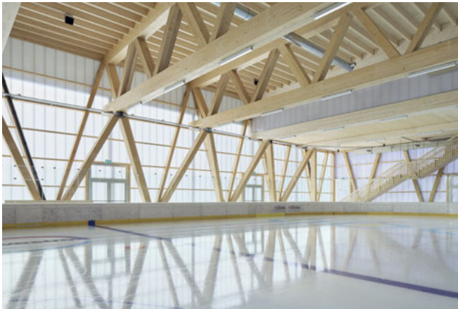
Die Holzkonstruktion lässt den Bau leicht erscheinen und die transluzente Gebäudehülle bringt viel Licht in die Halle.
